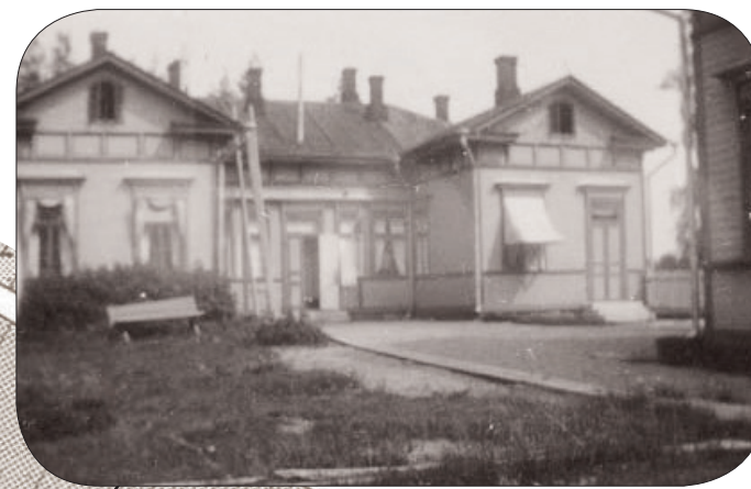
HAMINAN SAIRAALA Haminan kaupungin sairaala aloitti toimintansa 1.12.1899. Tässä Saviniemeen rakennetussa talossa oli viisipaikkainen sali miehille, viisipaikkainen sali naisille, kaksi yhden potilaan huonetta yksityispotilaille ja yhden potilaan eristys-huone.
