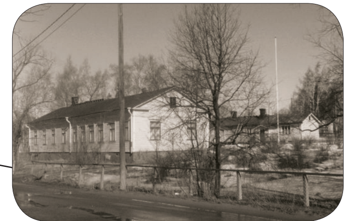
LASTENKOTI Mannerheimintien varrelle vuonna 1881 orpolapsia varten perustettu lastenkoti, johon voitiin sijoittaa 15 lasta. Toiminnan alkaessa pojat asuivat siellä 8-10 vuotiaiksi ja tytöt siihen asti, kunnes olivat käyneet rippikoulun. Myöhemmin ikärajaksi tuli 18v.
