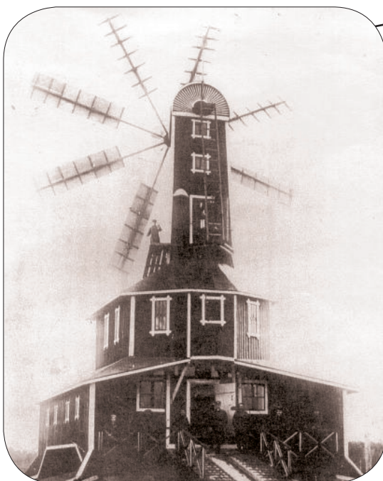
TUULIMYLLY Saviniemen kalliolle Takkaniemeä vastapäätä v. 1919 rakennettu kautta Etelä-Suomen tunnetun myllymestarin Oskar Frimanin suunnittelema ja rakentama harvinaisen upea kahdeksansiipinen tuulimylly. Taidokkaan suunnittelun ja toteutuksen myötä sitä pystyttiin kääntämään yhden miehen voimin kulloisenkin tuulen suunnan mukaisesti. Purettu jo 1920-luvulla.
